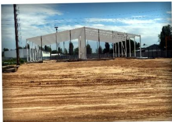
Огнезащита несущих металлоконструкций цеха, г. Волгодонск, Ростовская область
