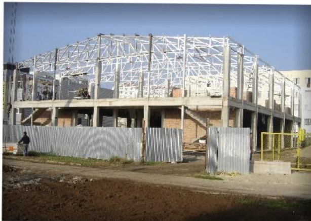
Огнезащита металлических конструкций кровли, г. Волгодонск, Ростовская область
