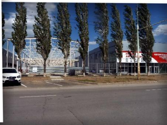
Огнезащита несущих металлоконструкций г. Волгодонск, Ростовская область
