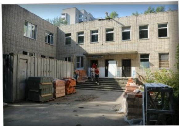
Огнезащита металлических лестниц, г. Волгодонск, Ростовская область
