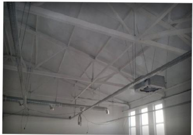
Огнезащита металлических конструкций кровли, г. Донецк, Ростовская область
