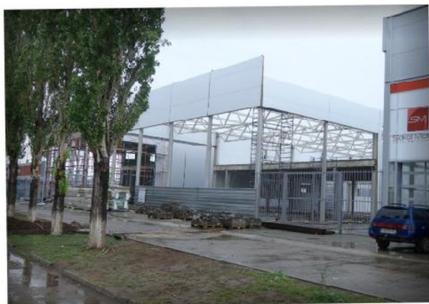
Огнезащита несущих металлоконструкций, г. Волгодонск, Ростовская область
