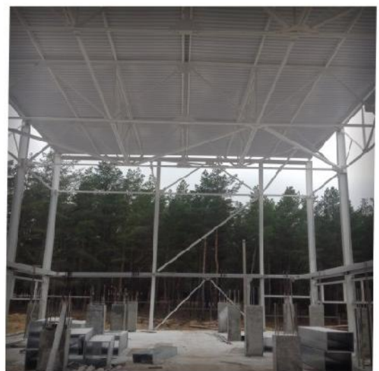
Огнезащита несущих металлических кровли, ст. Вешенская, Ростовская область
