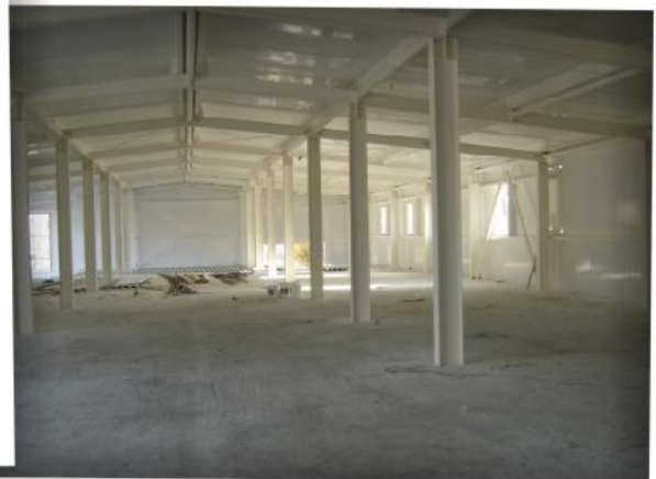
Огнезащита несущих металлических конструкций, г. Волгодонск, Ростовская область
