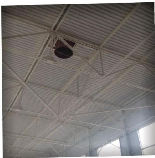
Огнезащита металлических конструкций кровли, ст. Вешенская, Ростовская область
