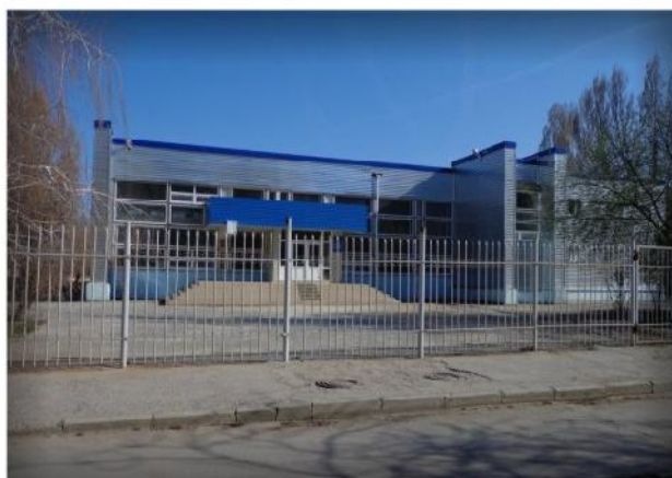
Огнезащита металлоконструкций кровли, г. Волгодонск, Ростовская область
