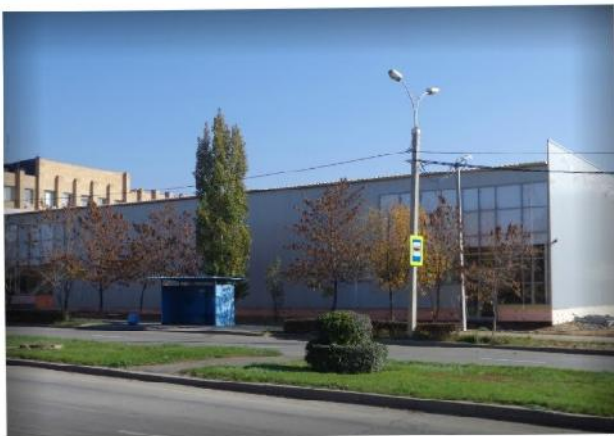
Огнезащита несущих металлических конструкций, г. Волгодонск, Ростовская область
