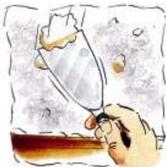
**1** Отверстия диаметром 80 мм в стене из дранки и штукатурки можно зашпаклевать мокрым шариком из газеты, смоченным в штукатурке, и покрыть его сверху штукатуркой. Если дранка повреждена, необходимо укрепить ее тонкой металлической сеткой. Поскольку сетка гибкая, Вы ее можете подогнуть так, чтобы она обогнула края под штукатуркой. Слегка подбейте ее молотком, чтобы она легла ровно. Нанесите мастерком тонкий слой закрепляющей штукатурки и просушите в течение часа.
